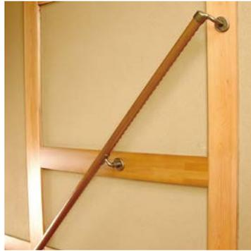
※転倒・転落を防ぐため、階段などの段差付近や足元が滑りやすい場所では、必ずすすりを連続させてください。
