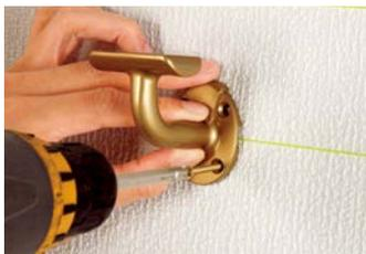
手すり取付け高さからブラケット座の中心までの寸法分下がった位置に水糸とピンなどでブラケット座の中心を出し、ブラケットの中心を水糸に合わせて下段の穴1か所をねじで仮止めします。
